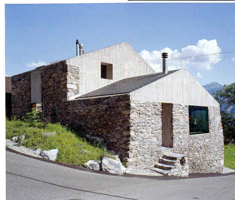
Le bois de l'ancienne construction a été remplacé par du béton.
